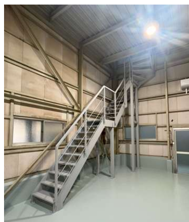
新設階段正面
